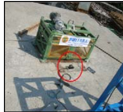
Fig. 19 - Accelerometro sul 2° impalcato
