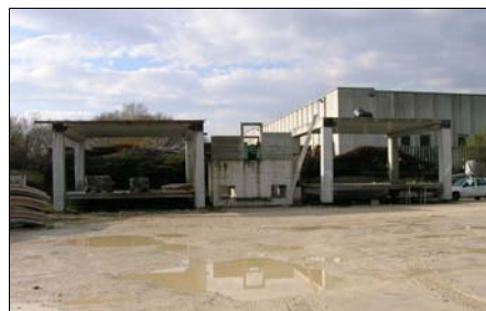
Fig. 1 - Telai studiati: a sinistra telaio a Base Fissa; a destra telaio a Base Isolata
